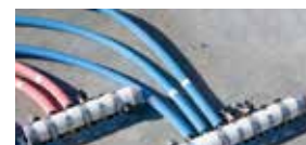
施工例(ヘッダー部拡大)
