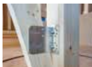
筋かい金物 柱と筋かいの接合に使用し、建物の強度をアップさせます。
