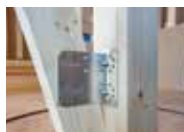
筋かい金物 柱と筋かいの接合に使用し、建物の強度をアップさせます。
